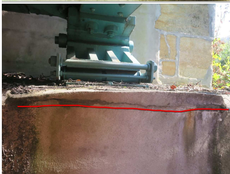
Foto č. 6 Opěra O 02 – úložný práh vpravo. Trhlina před ložiskem oddělující horní plochu úložného prahu.
