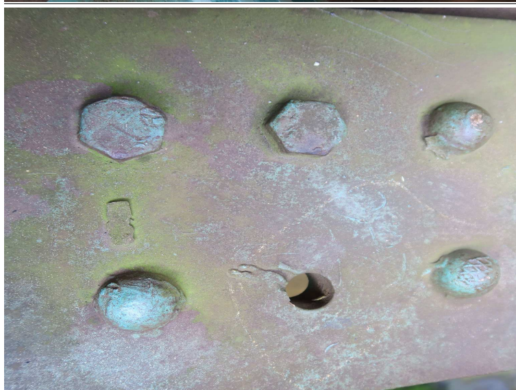
Foto č. 3 Konstrukce K 01 – příčník 1 vpravo pod kolejnicí. Chybí šroub v horní pásnici.
