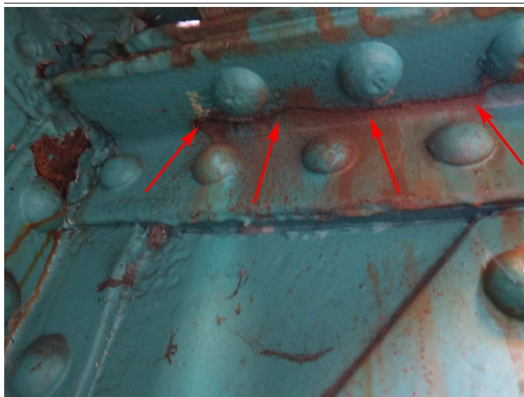
Foto č. 4 Konstrukce K 01 – podélník vpravo, konzola nad O 01 z vnitřní strany. Trhlina v krčném úhelníku.
