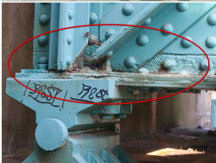
Foto č. 2 Konstrukce K 01 – hlavní nosník vpravo na uložení. Oslabení korozí a opětovné oslabování.
